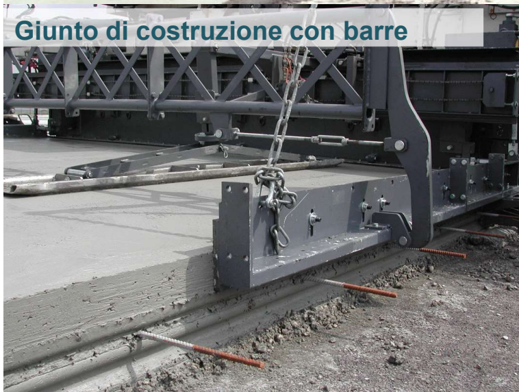
STESA CON MACCHINA A CASSEFORME SCORREVOLI
